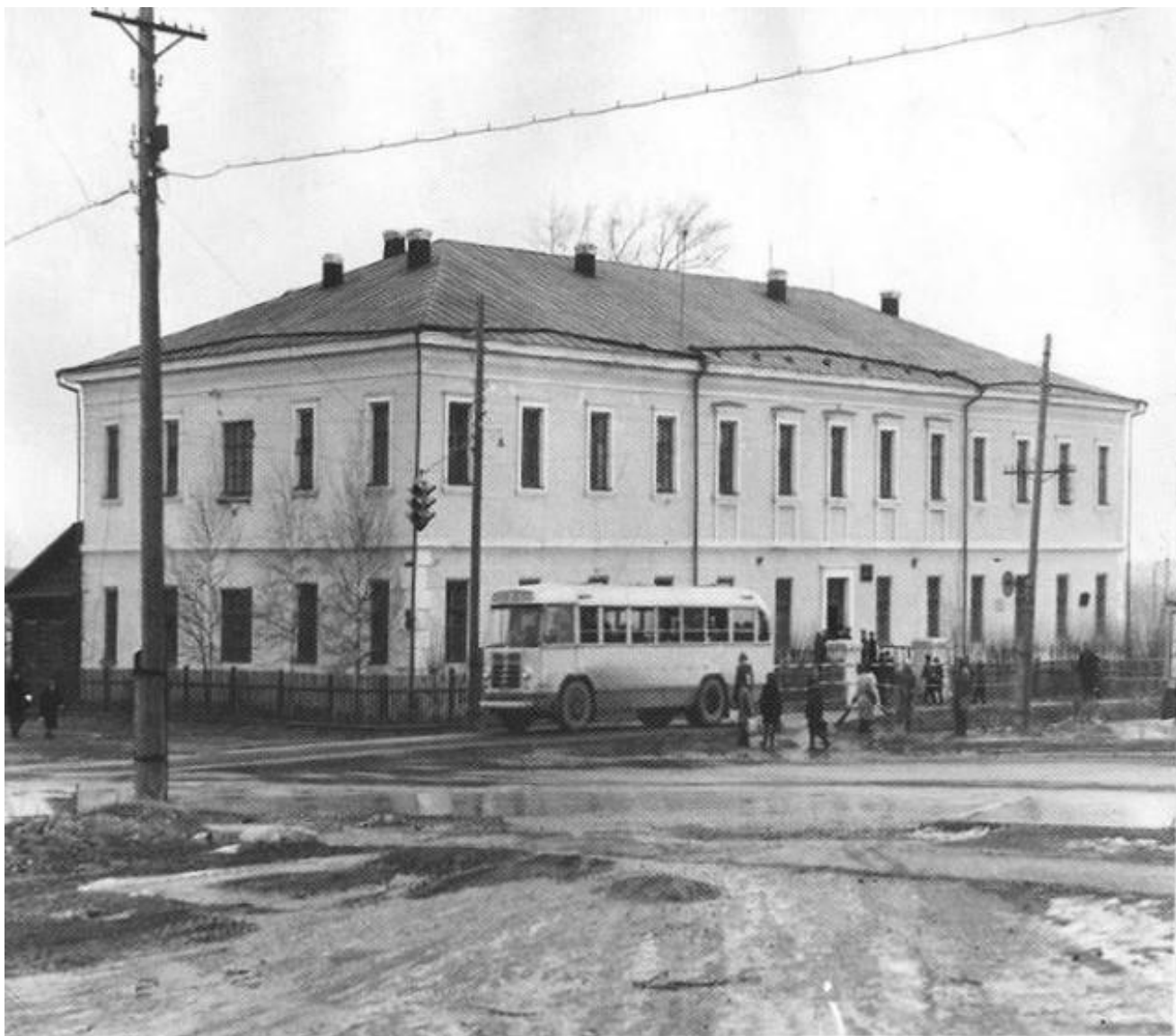
Рис. В.11. Объект культурного наследия «Здание, где работал профессор Санкт-Петербургского университета, основатель геологического музея Е. С. Федоров» расположенный по адресу: Свердловская область, г. Краснотурьинск, ул. Октябрьская, д. 45. Вид с юга. 1970-е гг.
