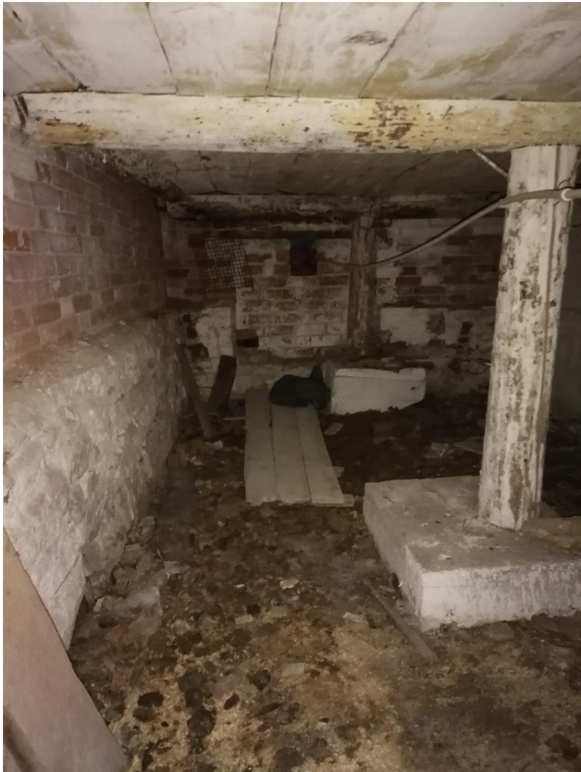
Рис. Г.55. Ф. 51. Объект культурного наследия «Здание, где работал профессор Санкт-Петербургского университета, основатель геологического музея Е.С. Фёдоров» по адресу: Свердловская область, г. Краснотурьинск, ул. Октябрьская, 45. Интерьер подвала. 2021.
