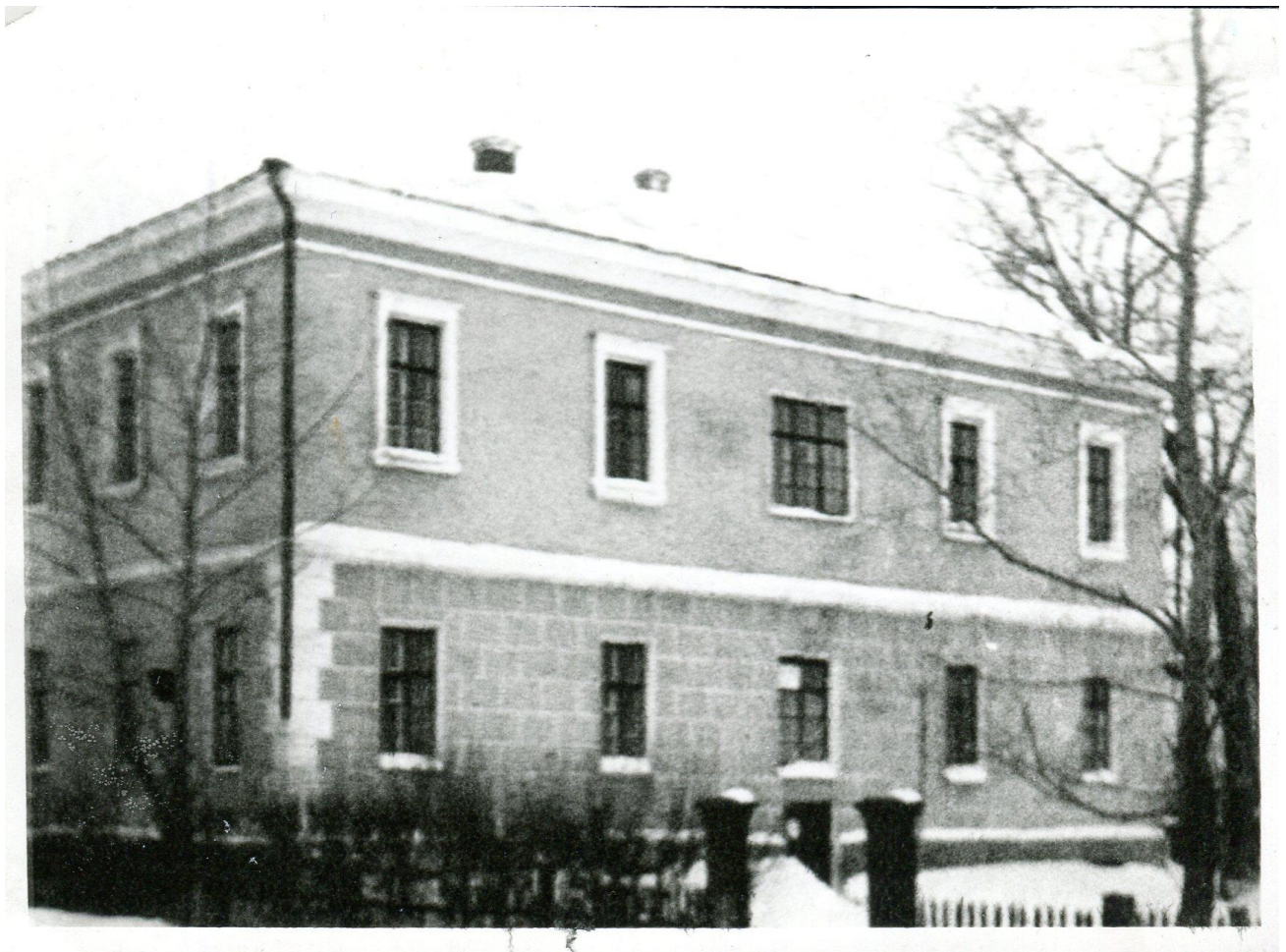
Рис. В.7. Объект культурного наследия «Здание, где работал профессор Санкт-Петербургского университета, основатель геологического музея Е. С. Федоров» расположенный по адресу: Свердловская область, г. Краснотурьинск, ул. Октябрьская, д. 45. Вид с востока. Первая половина XX века.
