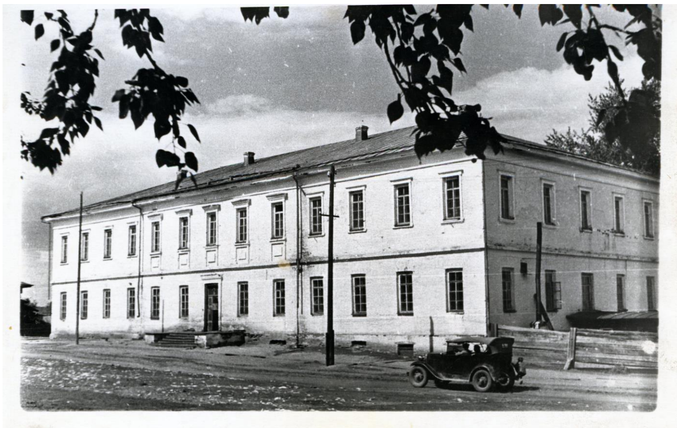
Рис. В.6. Объект культурного наследия «Здание, где работал профессор Санкт-Петербургского университета, основатель геологического музея Е. С. Федоров» расположенный по адресу: Свердловская область, г. Краснотурьинск, ул. Октябрьская, д. 45. Вид с юго-востока. Первая половина XX века.
