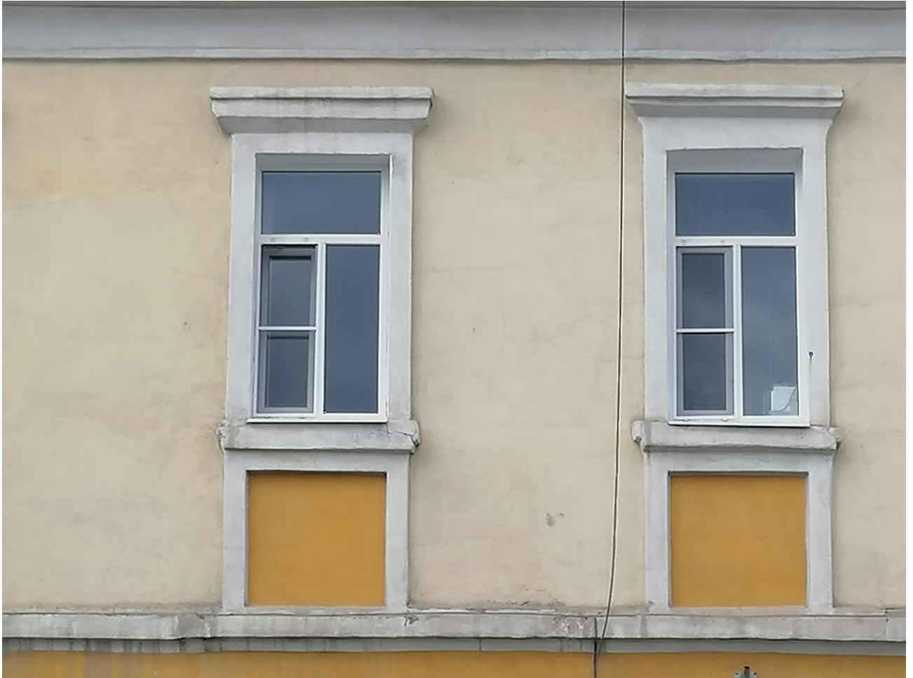
Рис. Г.7. Ф. 6. Объект культурного наследия «Здание, где работал профессор Санкт-Петербургского университета, основатель геологического музея Е.С. Фёдоров» по адресу: Свердловская область, г. Краснотурьинск, ул. Октябрьская, 45. Окна ризалита южного фасада. 2021 год
