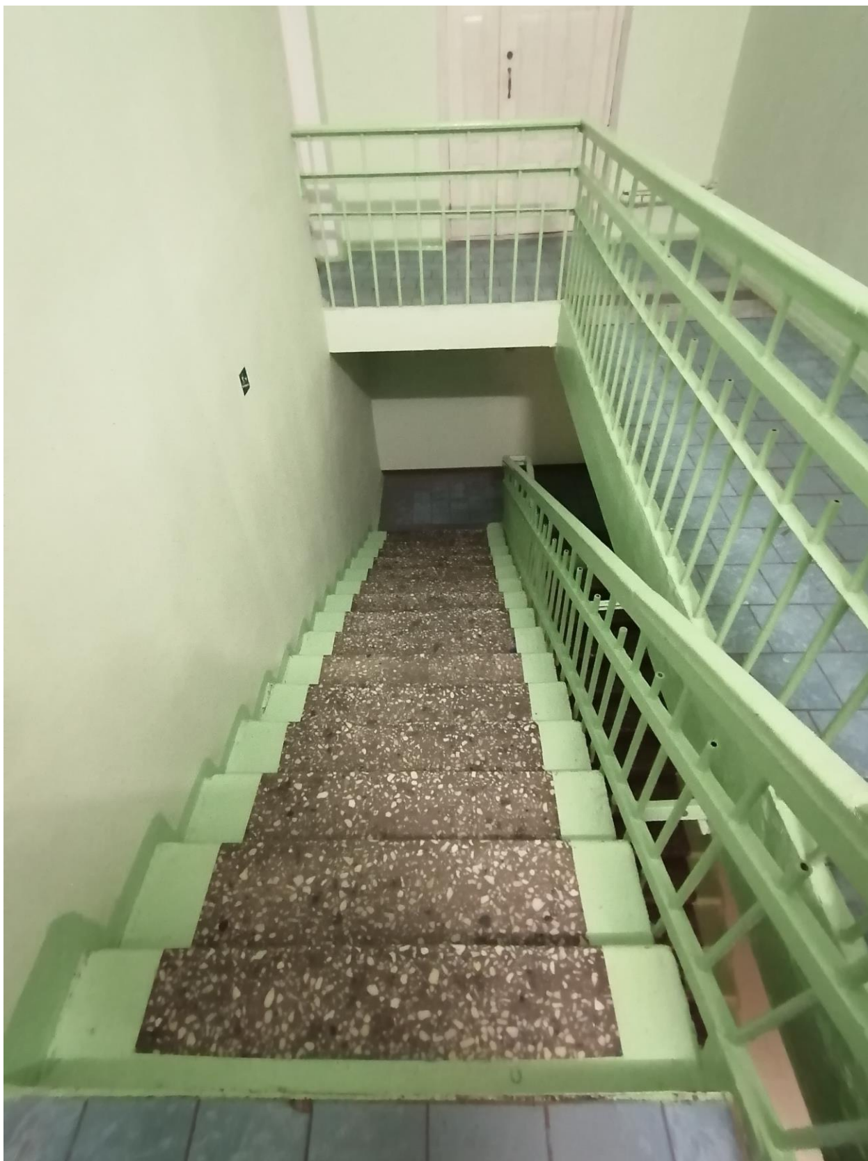
Рис. Г.43. Ф. 40. Объект культурного наследия «Здание, где работал профессор Санкт-Петербургского университета, основатель геологического музея Е.С. Фёдоров» по адресу: Свердловская область, г. Краснотурьинск, ул. Октябрьская, 45. Интерьер второго этажа. Лестница. 2021.
