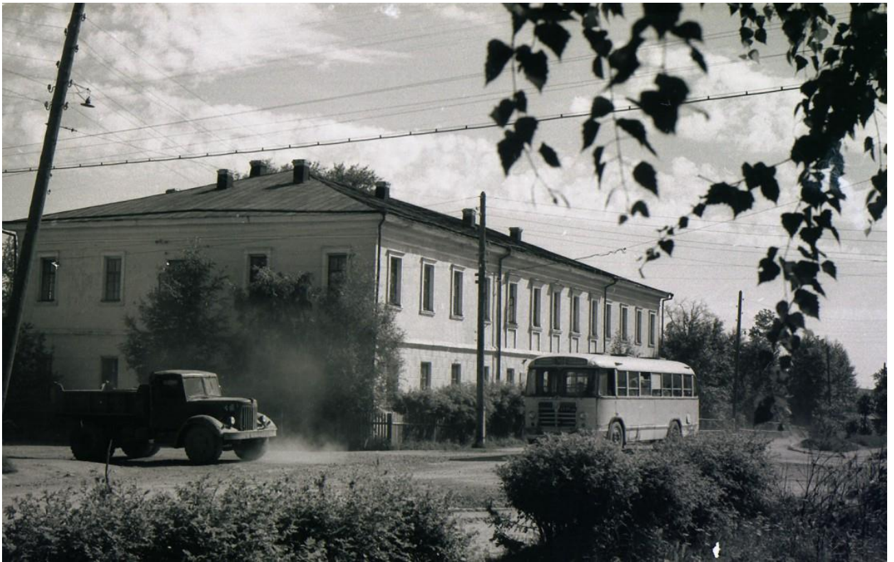
Рис. В.10. Объект культурного наследия «Здание, где работал профессор Санкт-Петербургского университета, основатель геологического музея Е. С. Федоров» расположенный по адресу: Свердловская область, г. Краснотурьинск, ул. Октябрьская, д. 45. Вид с юго-востока. Вторая половина XX века.
