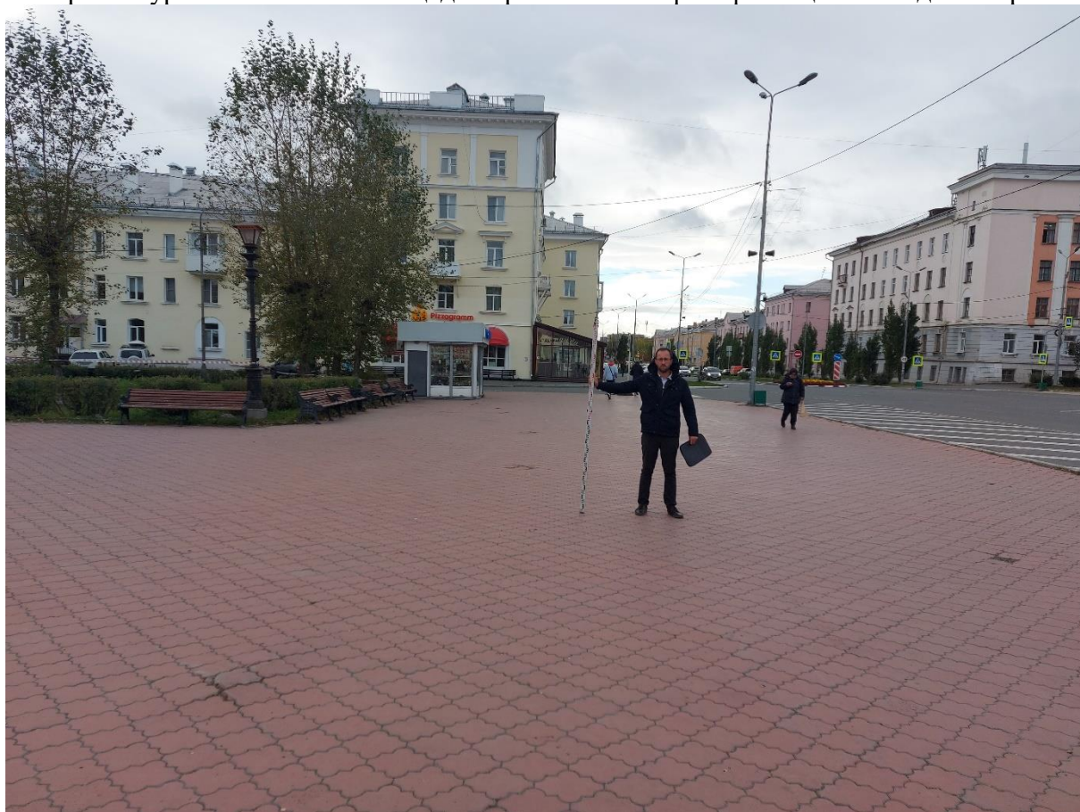
Рисунок 20. «Сердце «маленького Ленинграда». Благоустройство ул. Бульвара Мира в г. Краснотурьинске 1 этап. Площадь Героев». Точка фотофиксации 2. Вид с востока.
