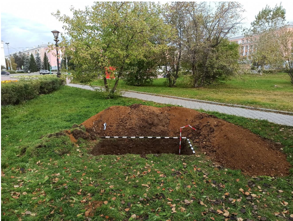
Рисунок 43. «Сердце «маленького Ленинграда». Благоустройство ул. Бульвара Мира в г. Краснотурьинске 1 этап. Площадь Героев». Шурф 2 после завершения исследований. Вид с юга.
